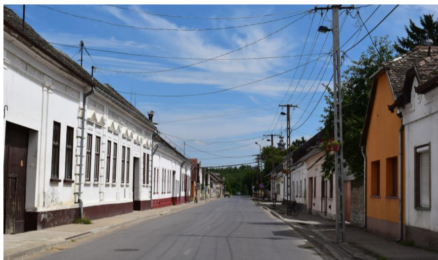
A Fő utca zárt sorú beépítése
