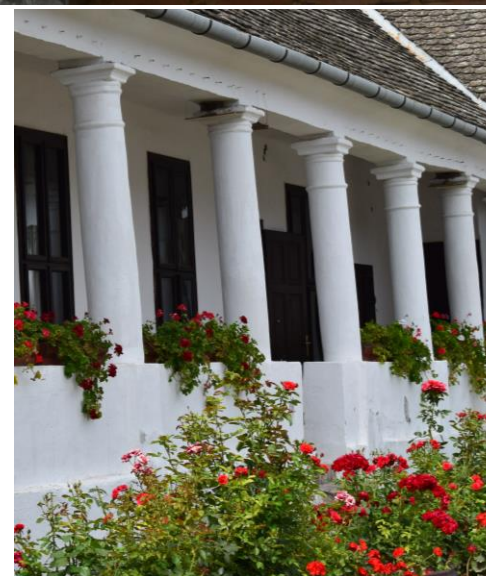
Falazott oszlopos tornácok
